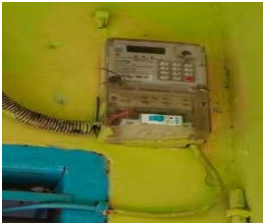
Penggunaan Listrik (kWh) Dusun I
